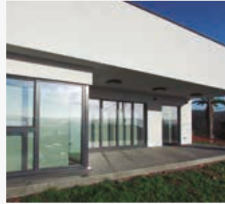
Passivhaus in Miño. Wohngebäude im Passivhausstandard. Miño, Spanien. Aquarea
